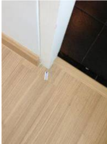
8. เก็บงานซึติโคนตรงวงกบประตูห้องน้ำ
