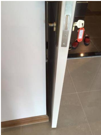
3. ติดกันชนประตู หรือลูกยางกันกระแทก (ไม่มี)
