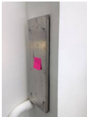
6.ทำความสะอาดฝาปิดตู้เมนไฟฟ้า
