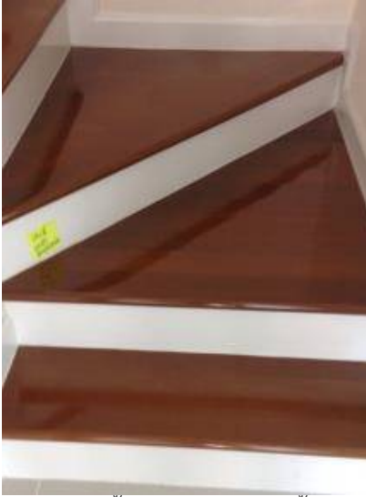
4. เก็บสีลูกตั้งลูกนอนบันไดทุกชั้น
