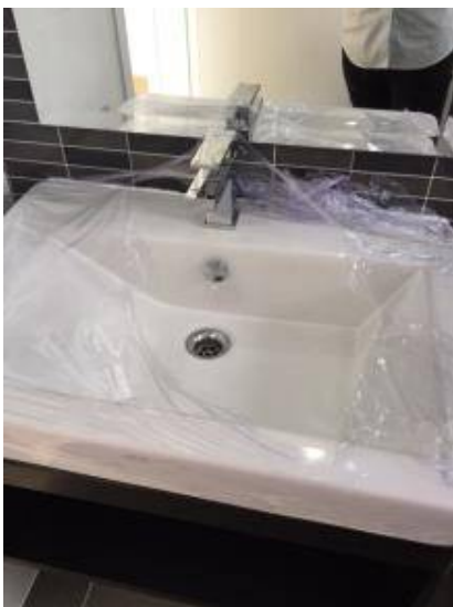
5. อ่างล้างหน้าไม่มีสะดืออ่าง
