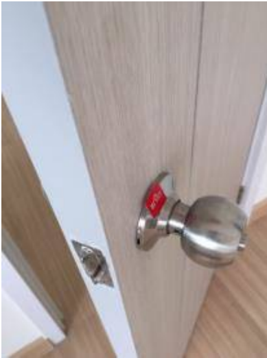
4.ติดตั้งลูกบิดประตูไม้เรียบร้อย+ลูกบิดเป็นคราบทำความสะอาด
