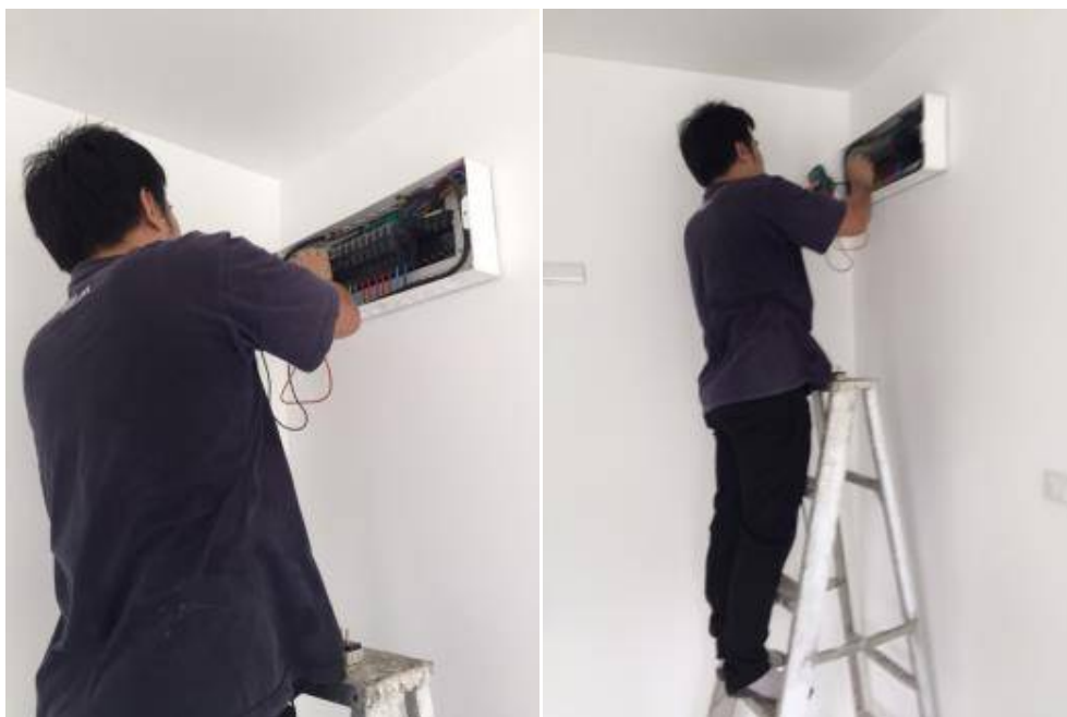
ระบบไฟปกติดี
