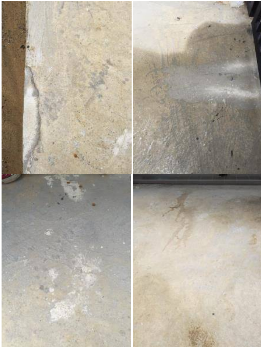
3.พื้นโรงรถ พื้นปูนร่อนสกัคซีปูนออก+เก็บงานปูนที่มีรอยแตกร้าว+ฉาบผิวบาง+เก็บสีหยดพื้น
