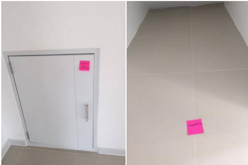
1. ทำความสะอาดประตู+เปลี่ยนจุกpvc 1 อัน
