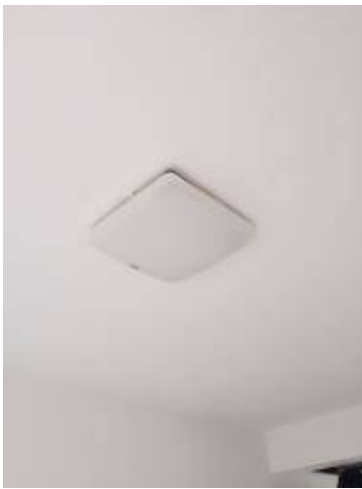
8.ติดตั้งโคมไฟให้เรียบร้อย
