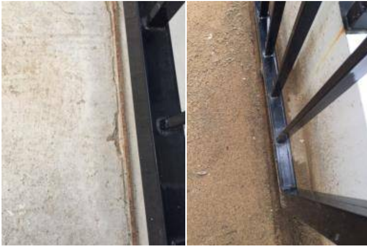
4.งานประตู่รั้ว เสาะดินออกจากราง+เก็บงานปูนแตก
