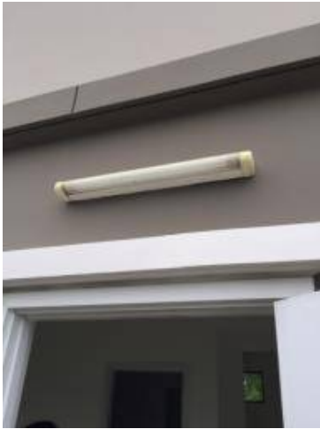
5. เปลี่ยนหลอดไฟใหม่
