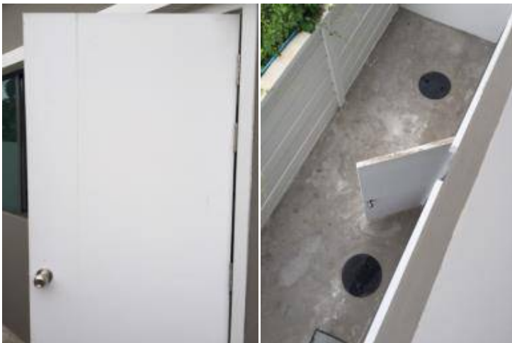
4.ทำความสะอาดประตูด้านบน
