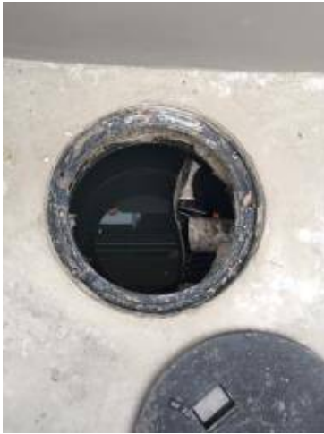
2.ทำความสะอาดถึงดักไขมัน
