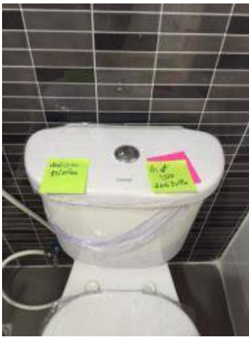
4. ติดตั้งลูกลอยชักโครกใหม่
